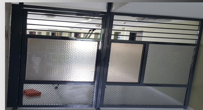
Structure métallique partie fixe et portillon
