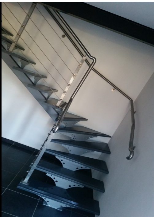
Escalier marches en bois - limon et garde-corps INOX
